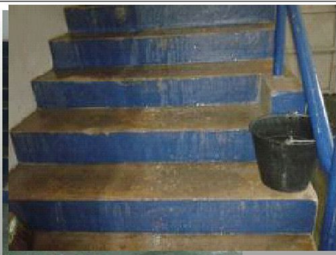
LIMPEZA DAS ARQUIBANCADAS
